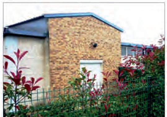
Les futurs locaux des Eaux de Briis à Briis-sous-Forges.
