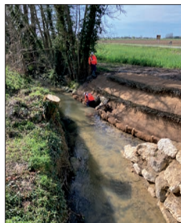
Photo de couverture : "Travaux de lutte contre les inondations sur la Prédecelle" Mai 2026.
